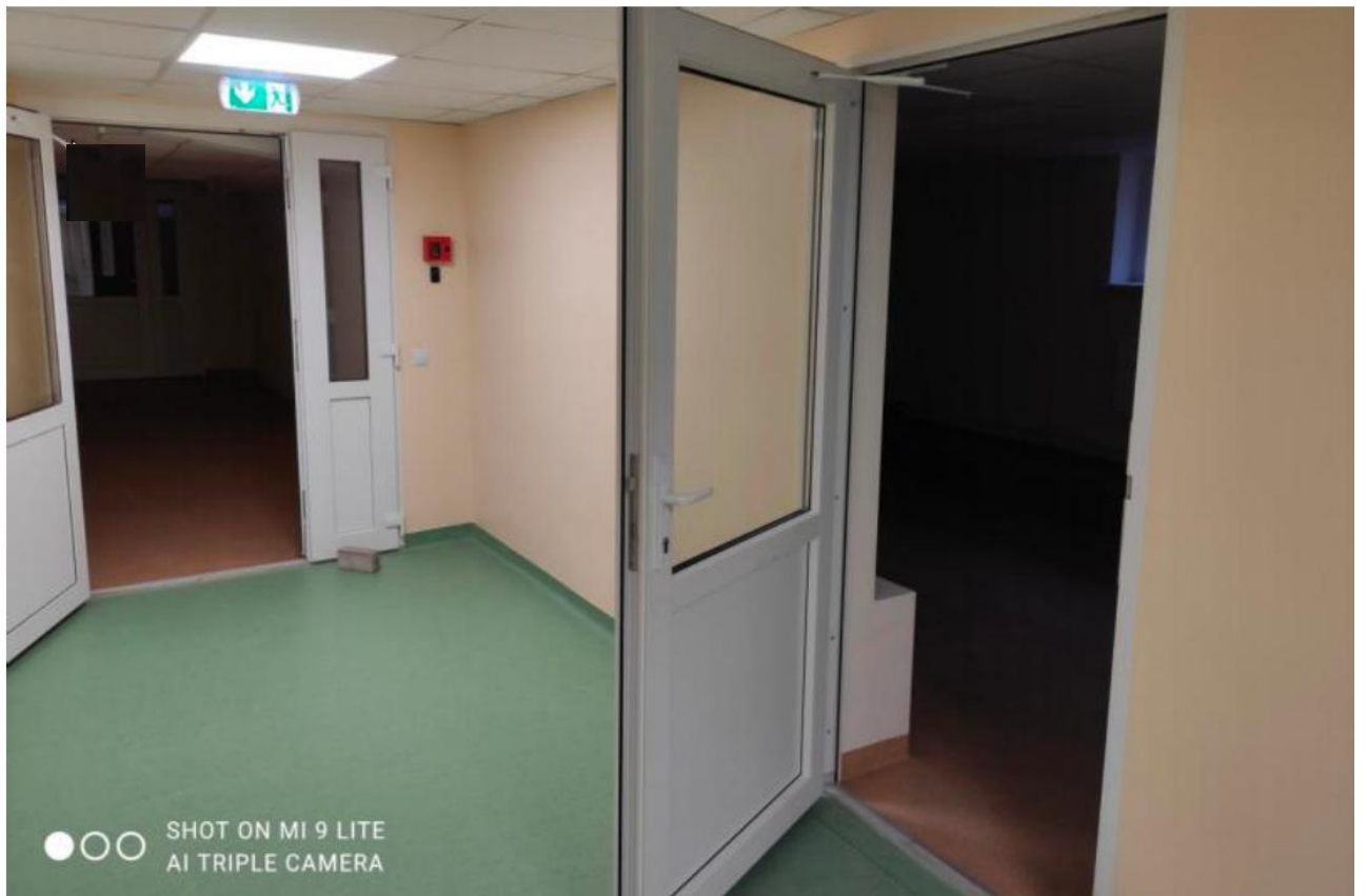
Medienos dirbtuvių patalpos po remonto
